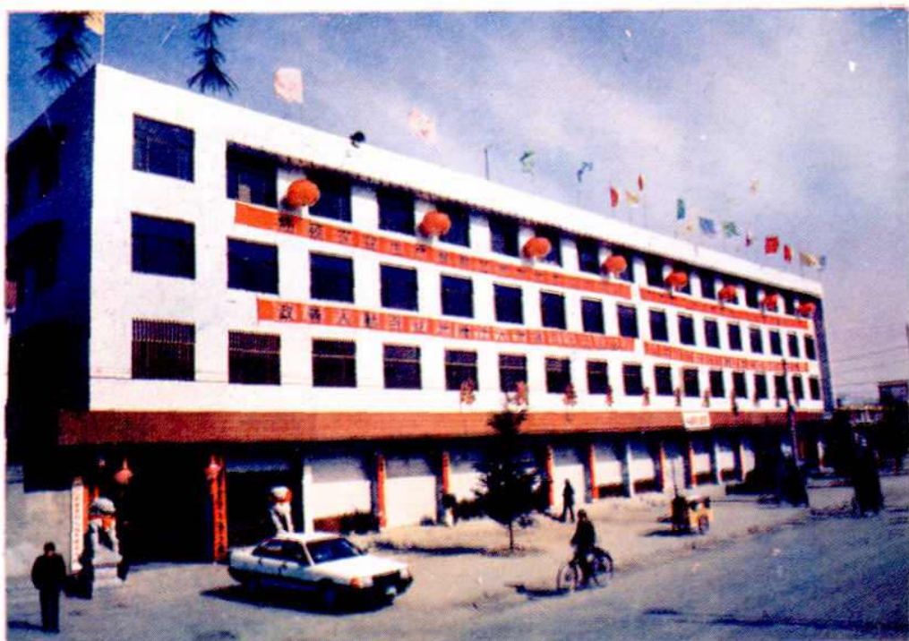
县农资公司办公大楼
