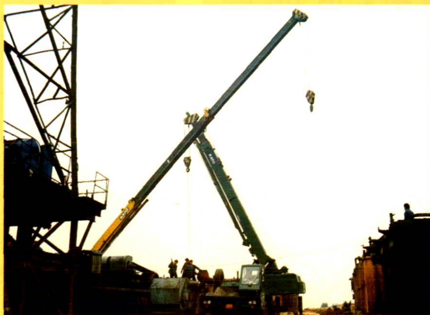
钻井队搬家安装
