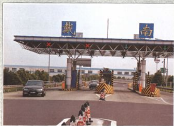
宁靖盐高速公路戴南互通口
