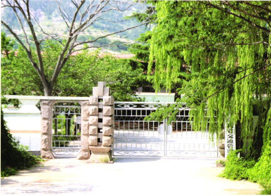
位于五龙域内的交通管理站
