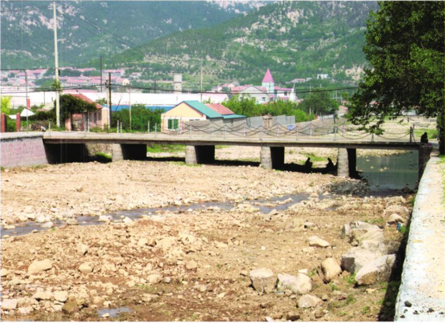
五龙入村大桥
