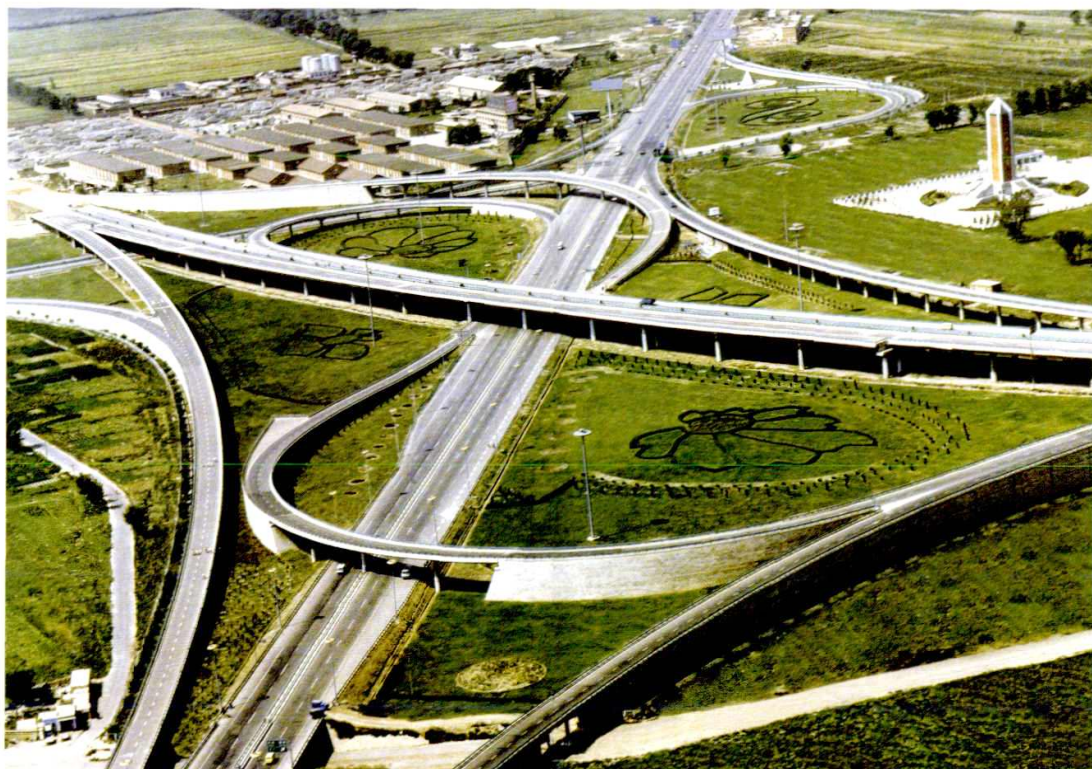
● 连通太旧、大运、环城高速公路的武宿立交桥
