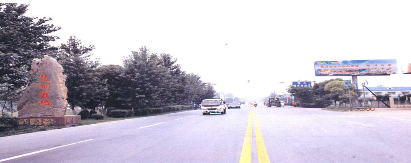
207国道宜城境内长38.5千米，图为北入口段（2010年摄）
