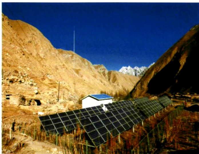
叶城县西合休乡大山深处太阳能集热供电设施
