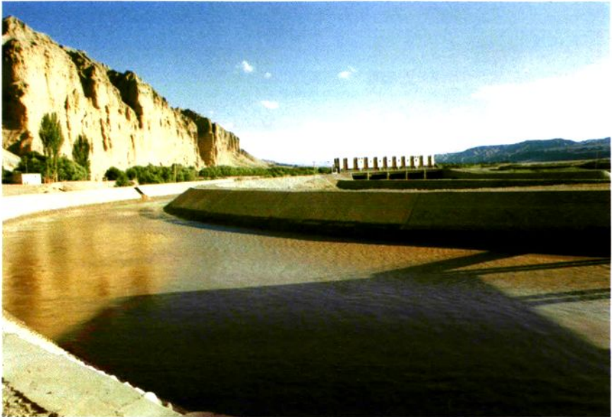
叶城县提孜纳甫河上的引水灌溉工程
