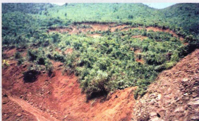
2004年5月19日，连续强降水造成连南至连山路段山坡发生大面积山体滑坡
