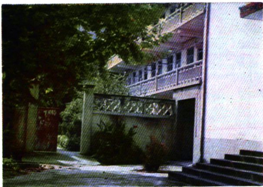
县农业局办公楼
