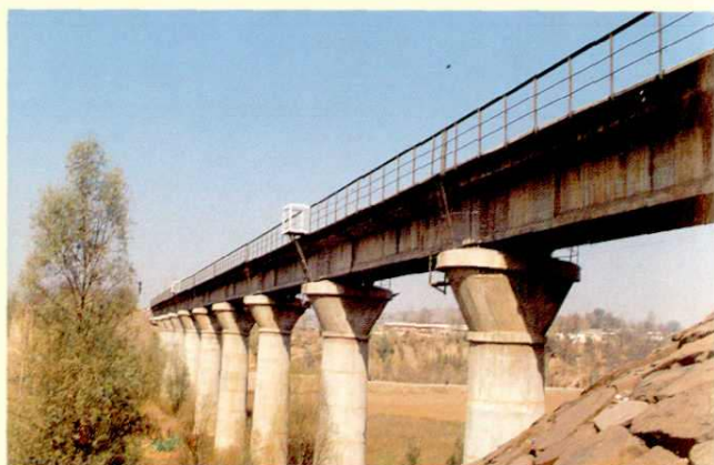
鹿亭铁路大桥
