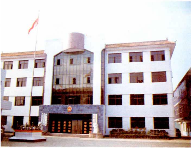
城关镇党委政府办公楼
