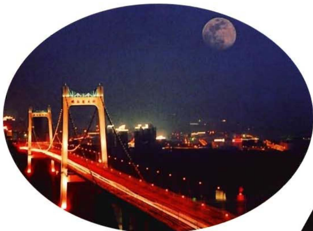
■ 鹅公岩大桥东锚碇区隧道监测，获2004年重庆市优秀工程勘察二等奖。
