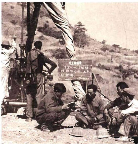
■ 成昆铁路选线勘察施工现场。
