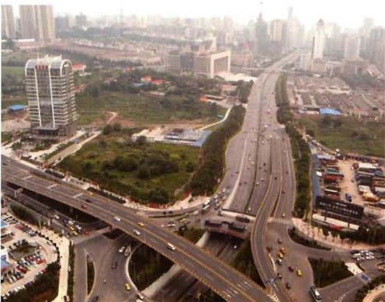
■ 南江队承担的重庆市渝北区新牌坊立交勘察。
