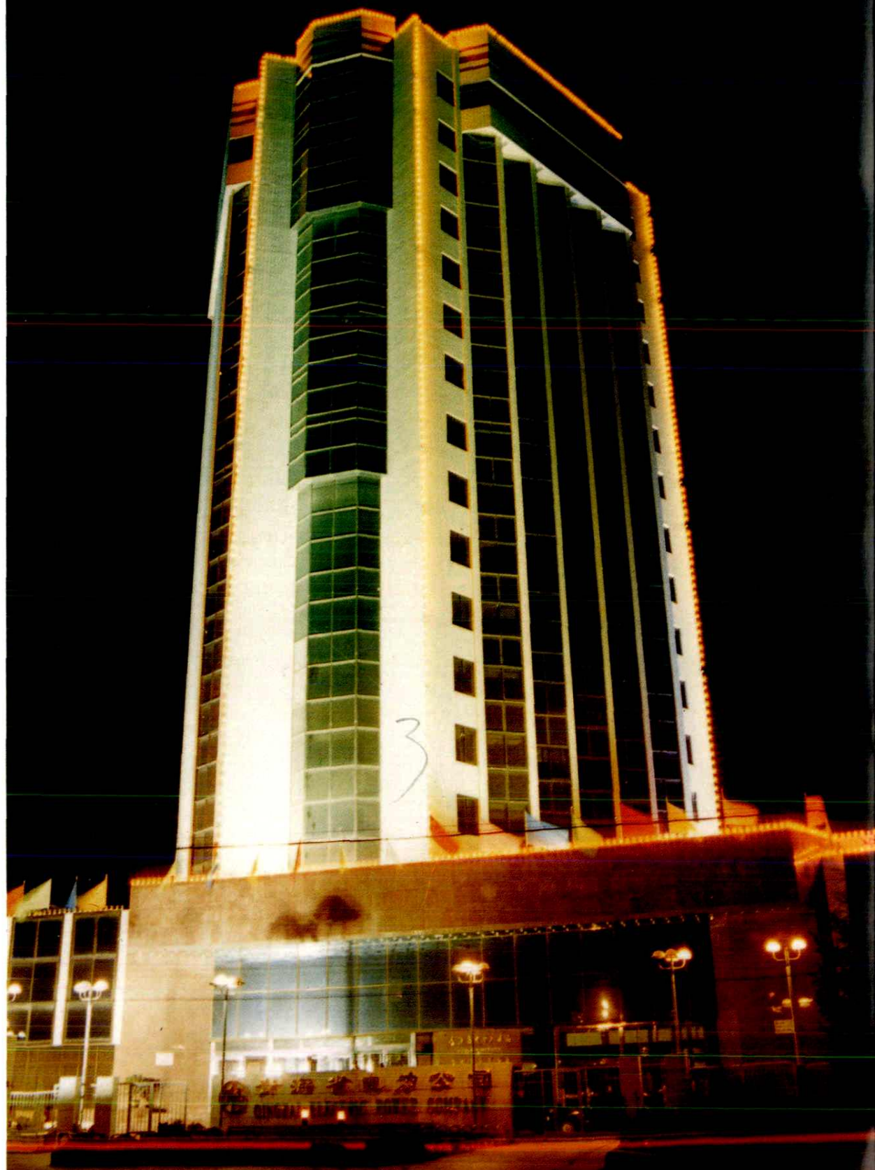
1 青海省电力工业局（青海省电力公司）大楼全景
