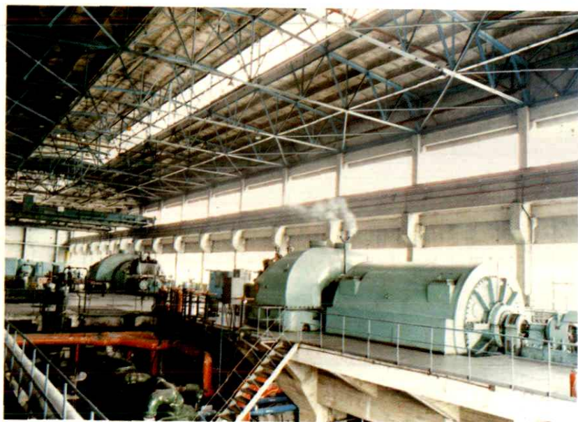
11 桥头发电厂 2 \times 2.5 万千瓦及 2 \times 5.0 万千瓦汽轮发电机 组
