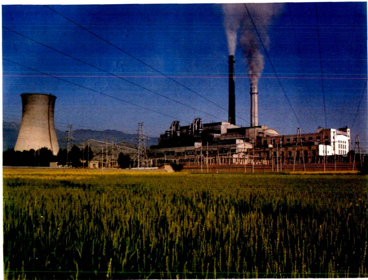
9 桥头发电厂(18.6万千瓦)外景
