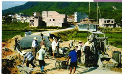
仙马公路改建水泥路面
