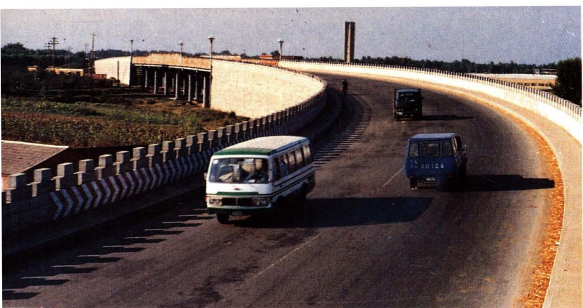
跨越铁路的京深 公路涿县立交桥
