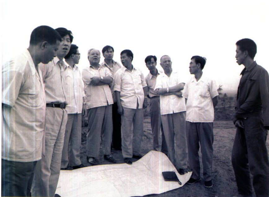
原煤炭部部长于洪恩（左四）在成庄矿井建设工地视察
