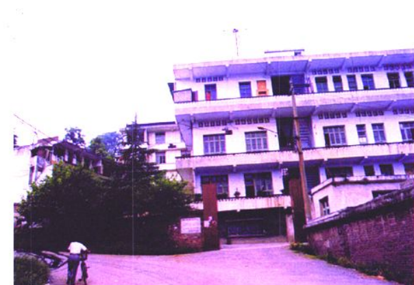
位于西山坡的原机关办公楼
