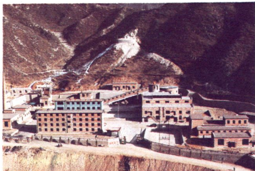
八道河金矿选矿厂
