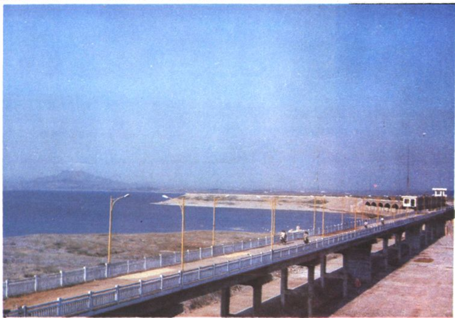
跋山水库溢洪闸
