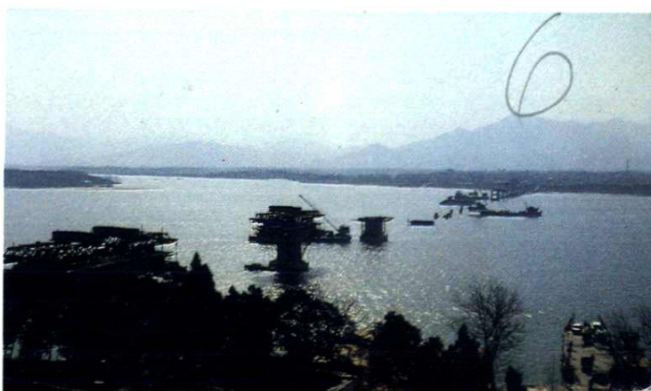
建设中的富阳大桥
