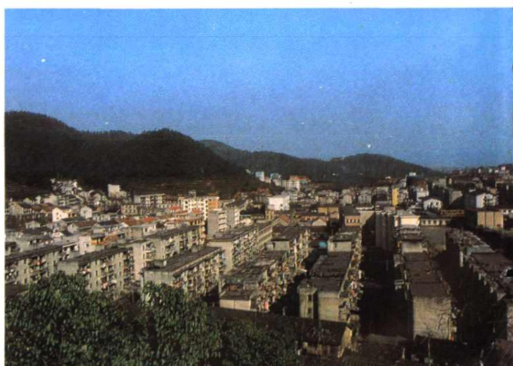
富阳镇新建居民区一角
