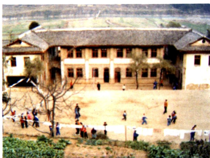
南坝老校舍工字型教学楼
