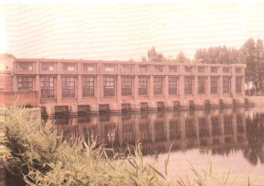
◀ 高坑扬水站外景
