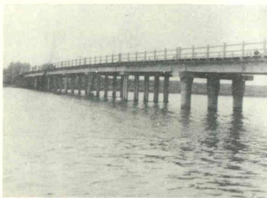
善后河大桥是通榆线上的主要桥梁之一。一九七五年十月始建，一九七六年五月竣工。全长一百五十六点五米，桥面净宽七米，高十米。“T”桥梁，混凝土灌注桩，九孔，桥孔净宽十五点七米，荷载汽—13T。
