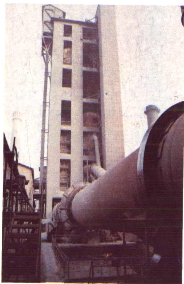
本溪水泥厂烧煤窑外分解窑
