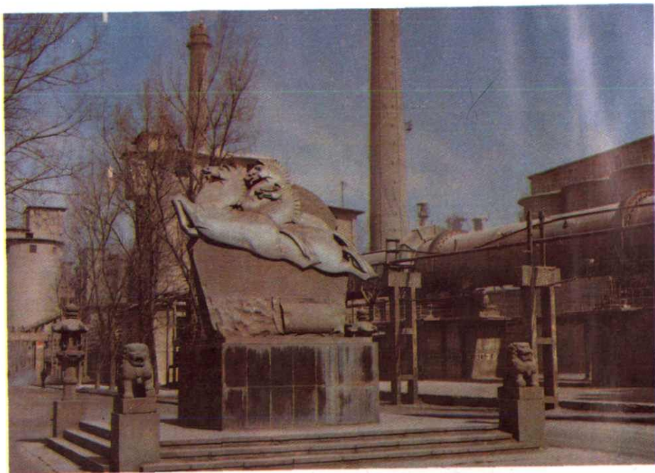
瓦房店水泥厂回转窑生产线
