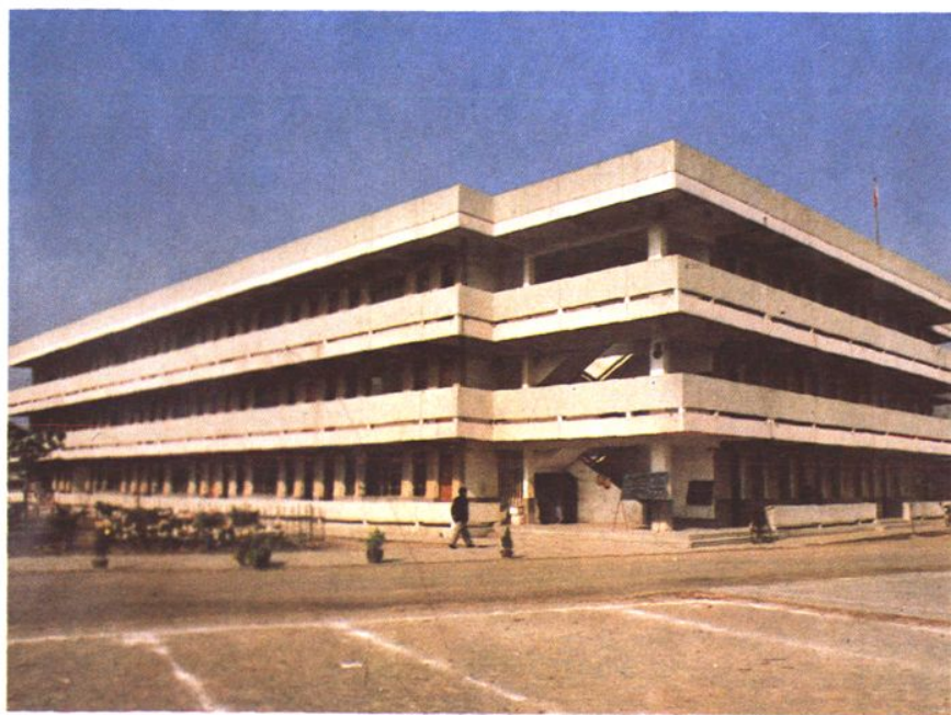
六合一中，用勤工俭学收入，盖起这座教学大楼。
