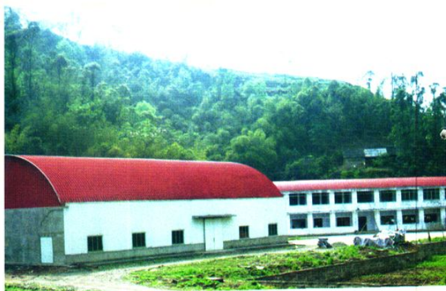
建设中的亚纳米厂
