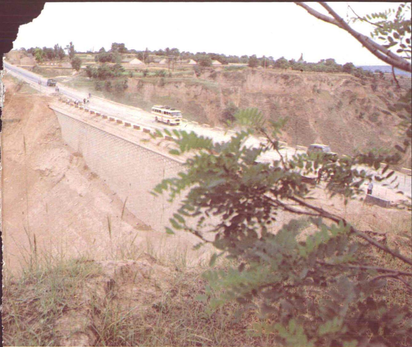
古寨新桥——冉店桥
