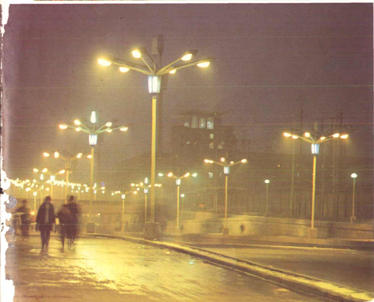
西兰路立交桥
