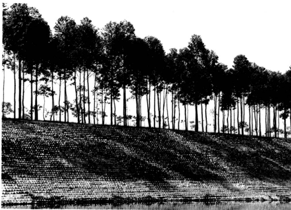
金马河天星渡堤防工程
