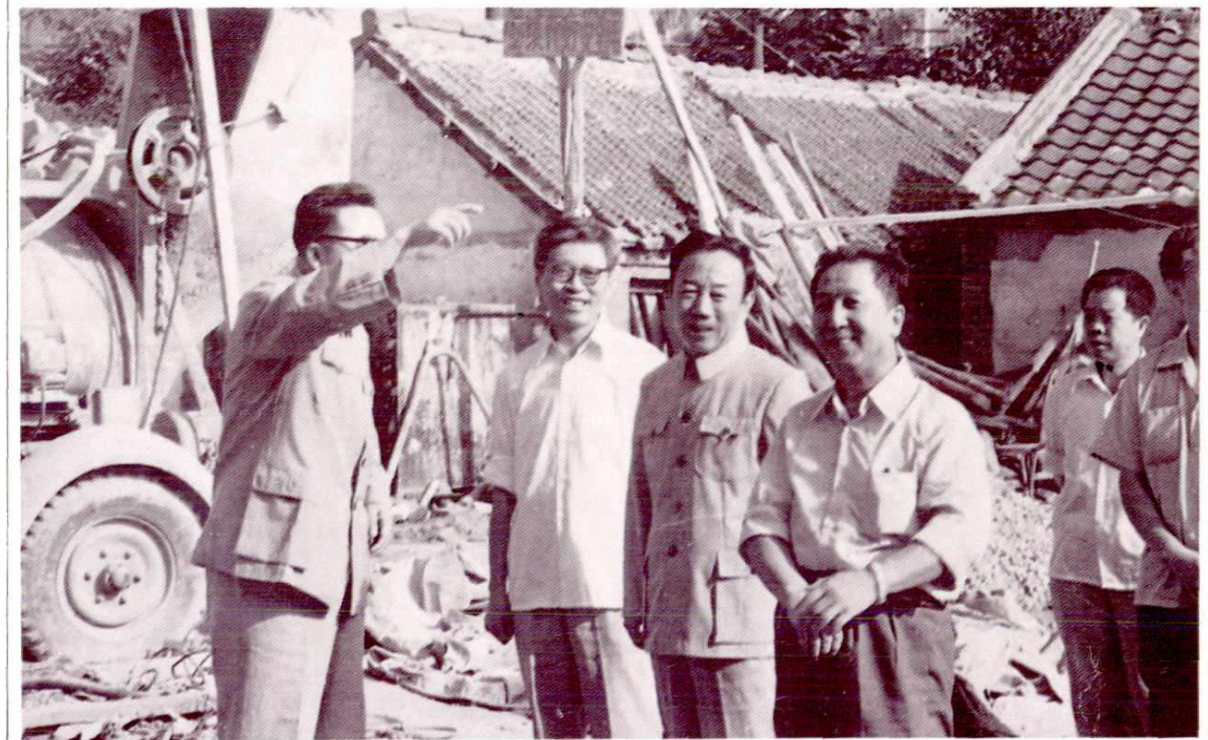
保险总公司副总经理张崇福（左四），省公司副总经理廖云（左二）、烟台市副市长姜德华（左一） 视察烟台保险公司办公大楼 基建工地
