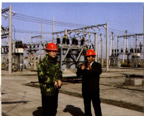
生产局长吴传发深入110千伏变电所秋检现场(2010.4)
