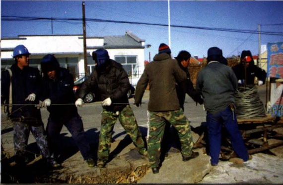
专职电工交换导线工程(农网改 造施工现场)
