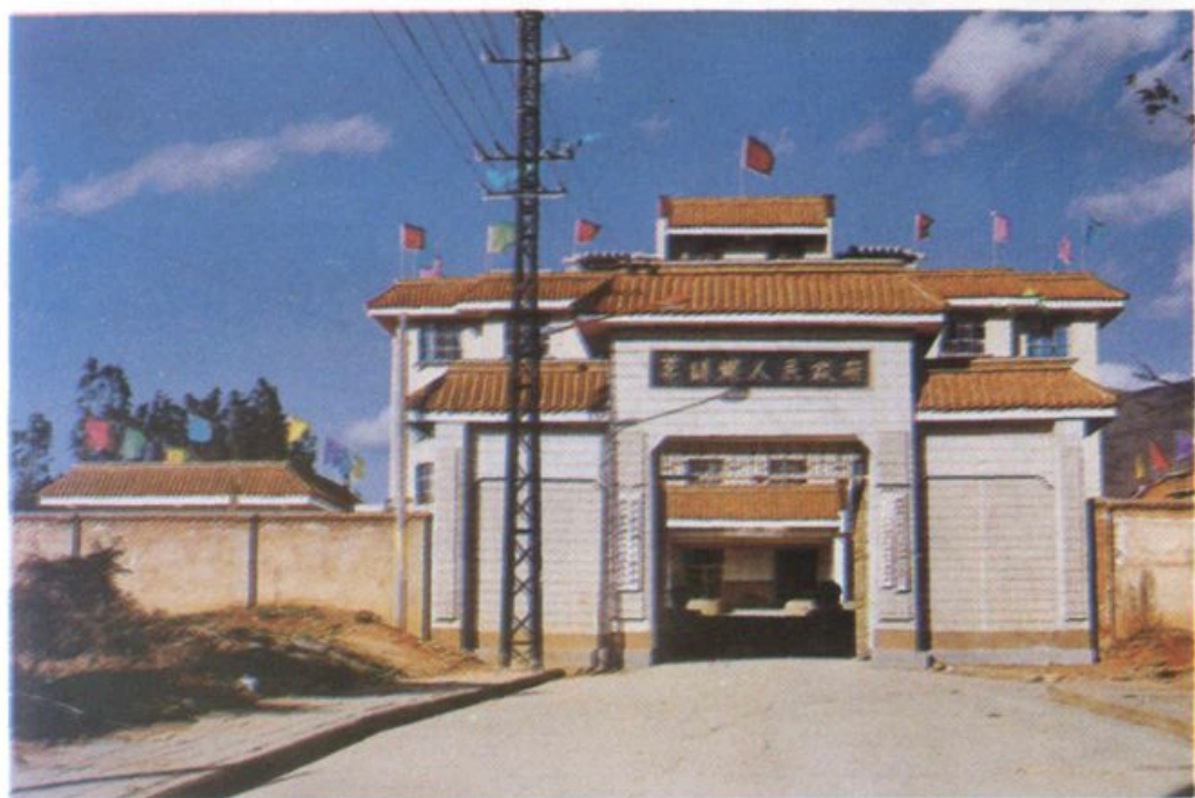
草鋪乡人民政府办公楼
