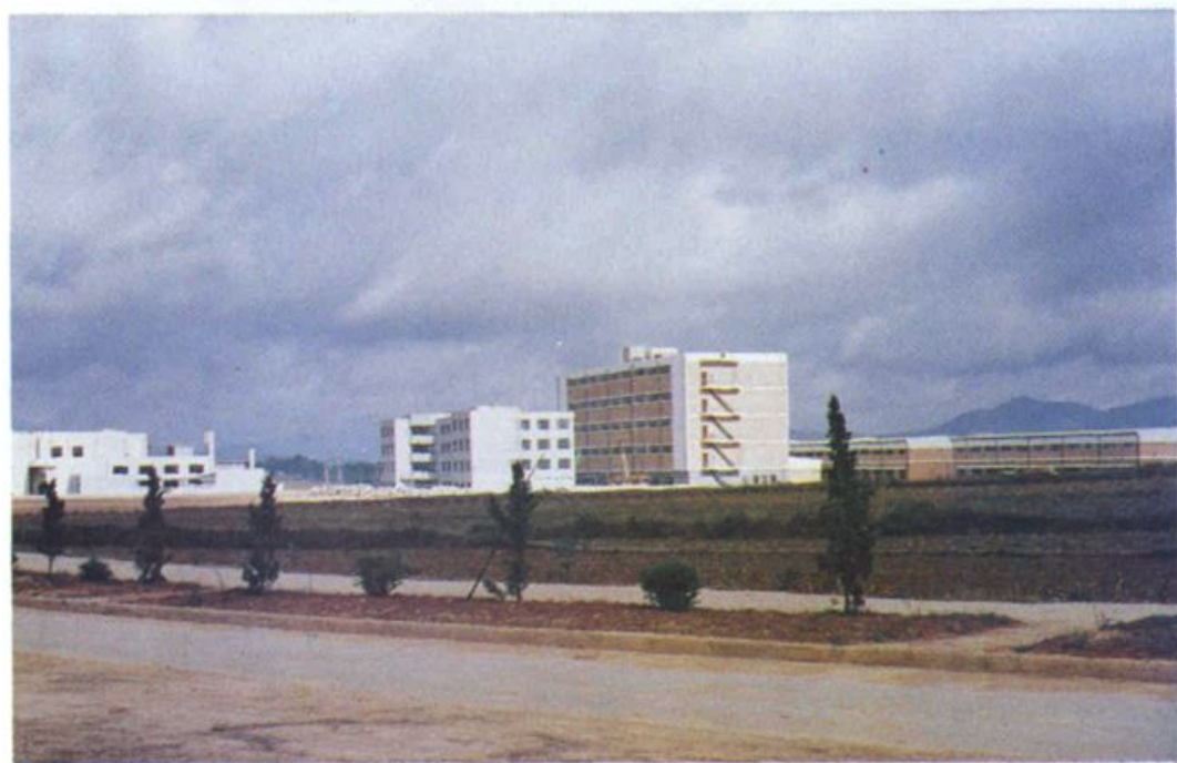
建在草铺的省重点工程——云南磷肥工业基地
