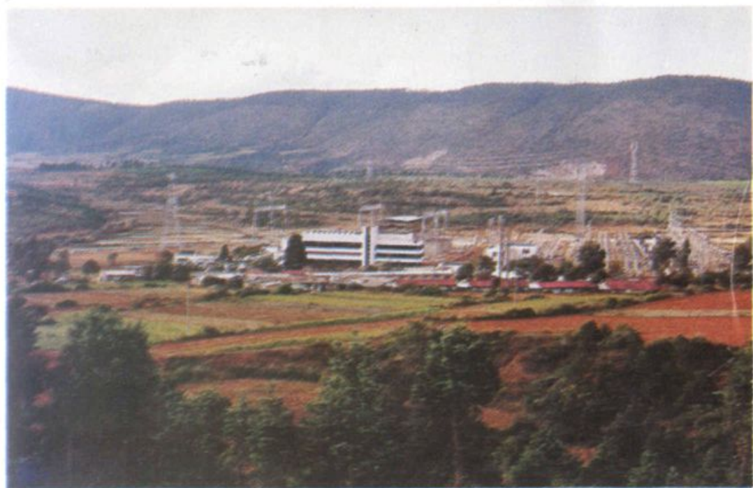
云南最大的变电站一建在草鋪的 超高压 50 万伏变电站
