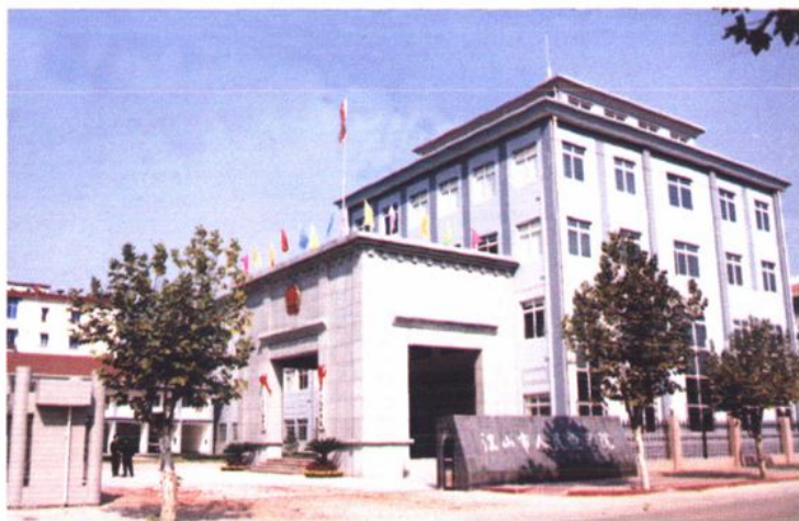
江山市检察院办公楼
