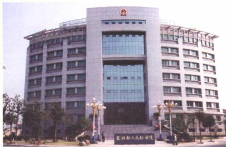
龙游县检察院办公楼
