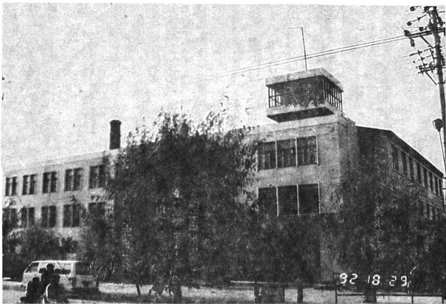
县交通局办公楼
