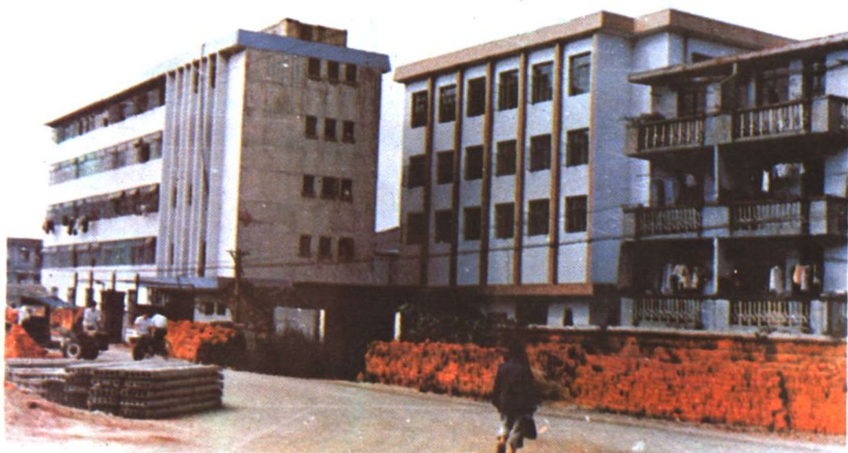
范道建筑站无锡工区样板工程
