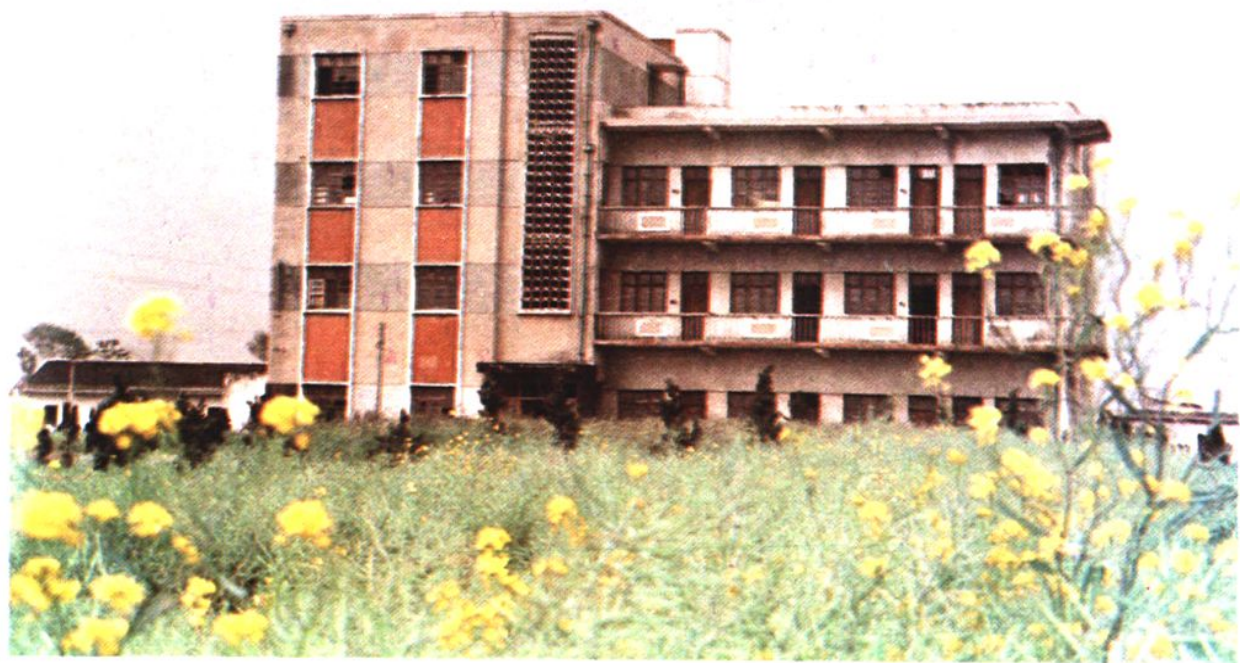
范道农科站大楼
