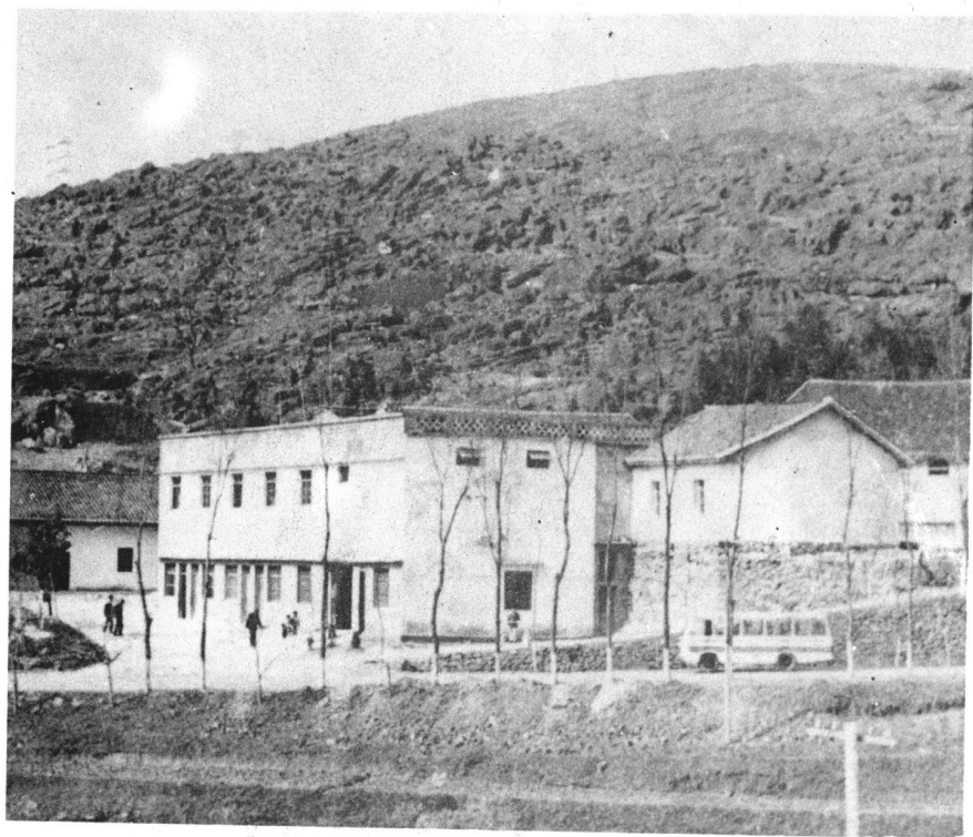
位于湖南澧县与我县山区接壤处的青坪粮站
