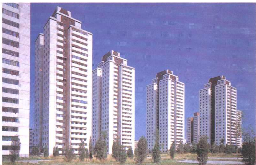
安慧南里住宅楼
