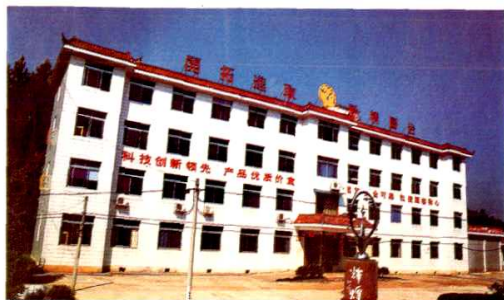
达浒出口花炮总厂全貌
