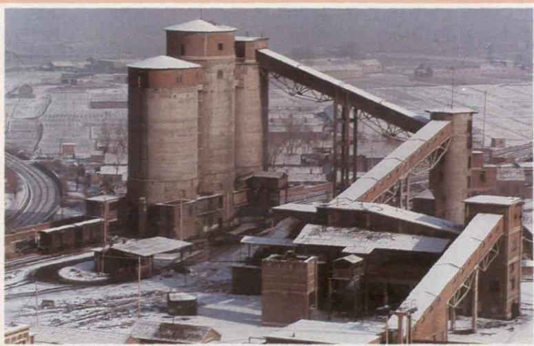
寨里煤矿北大井一角
