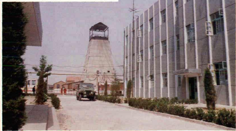
建设中的山后寨矿井
