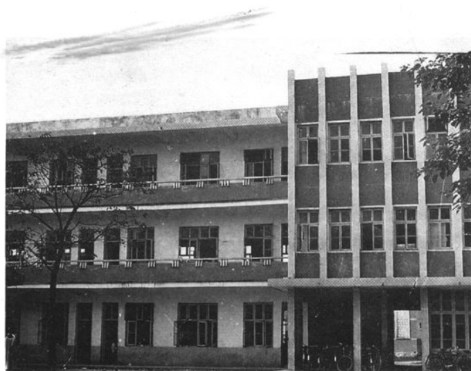
五中教学大楼
