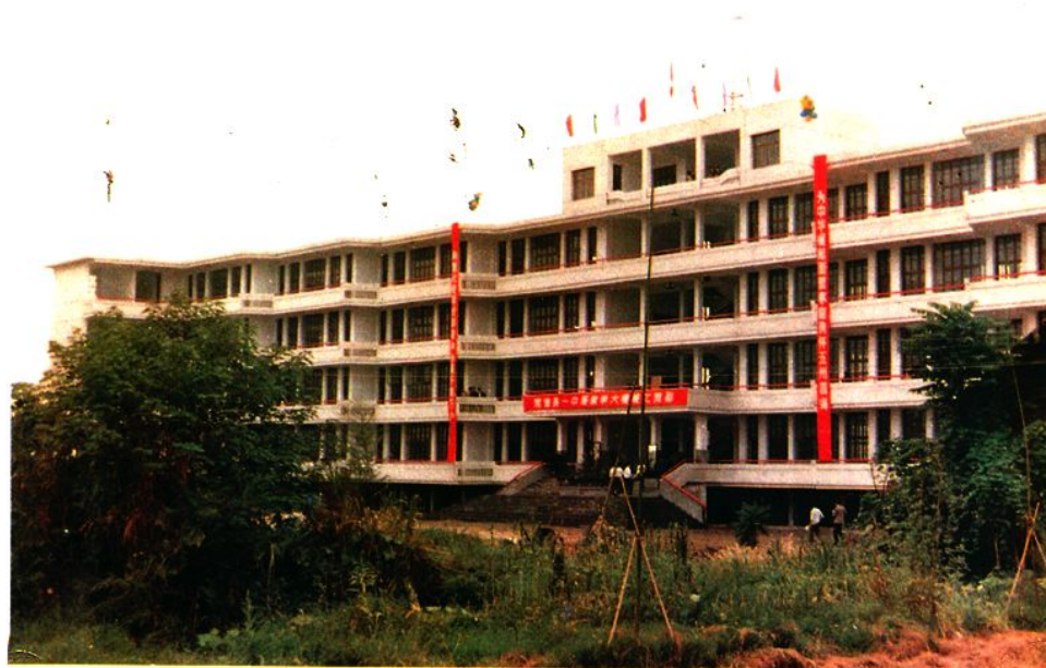
武陵中学新建教学大楼
