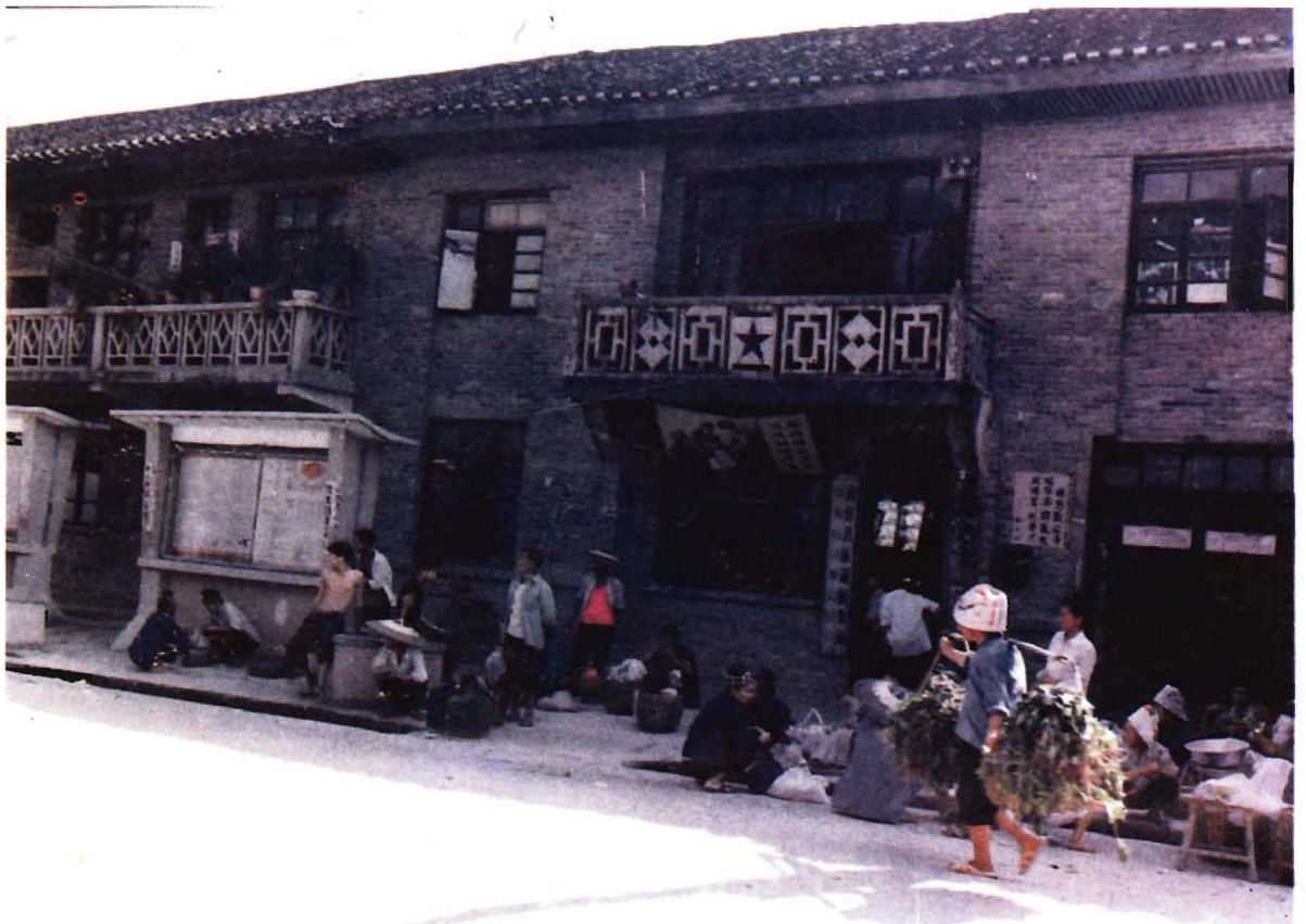
施洞税务所综合办公楼(1985年扩建)
