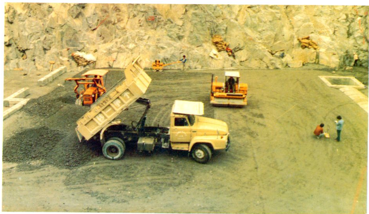
80 年代,科技兴水,赶超先进,紧跟时代! (RCC 筑坝)
