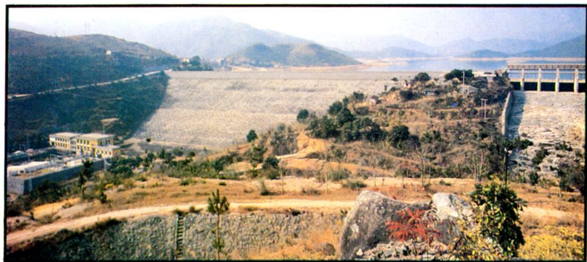
△东圳水库土石混合坝高 59 米,总库容 4.3 亿米 3 ,于 1960 年建成。
