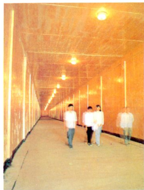
地下厂房交通洞
