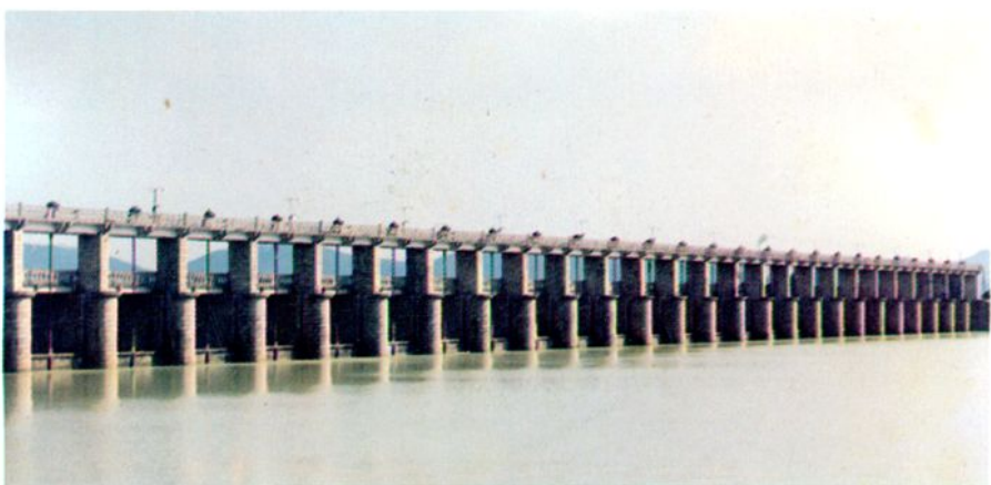
云霄漳江水闸 34 孔, 全长 211m, 1966 年建。
