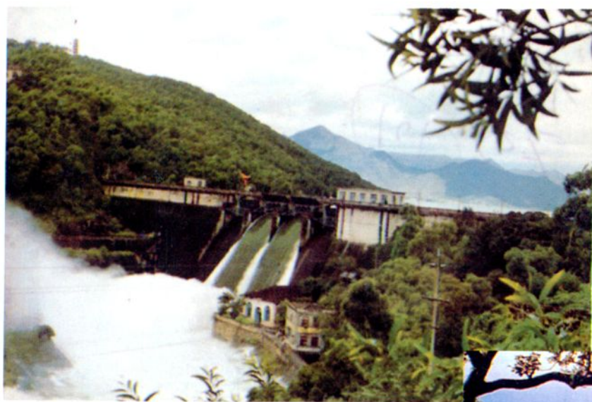
东张水库溢洪
