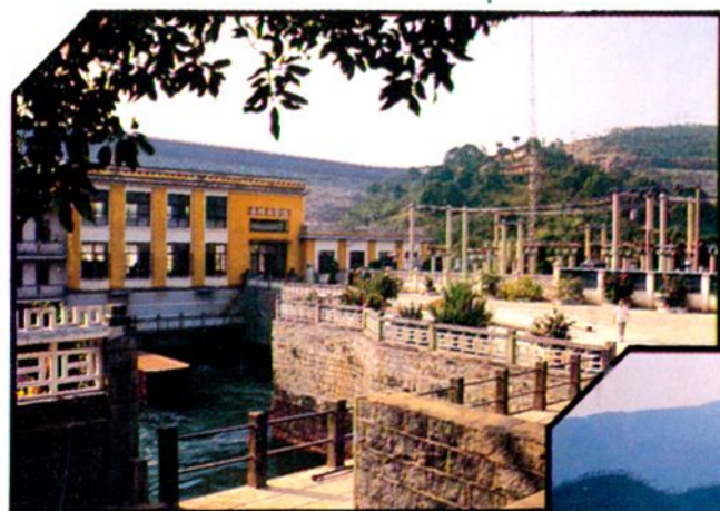
◁东圳水库坝后电站
