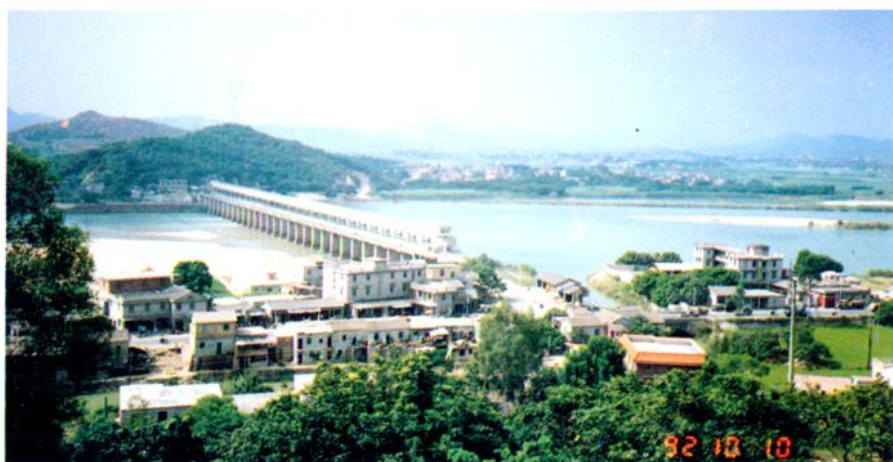
金鸡拦河闸 28 孔长 327m, 1967 年建, 是山美水库第一分水枢纽。
