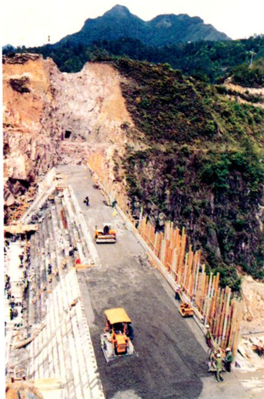
△碾压砼坝施工场景
