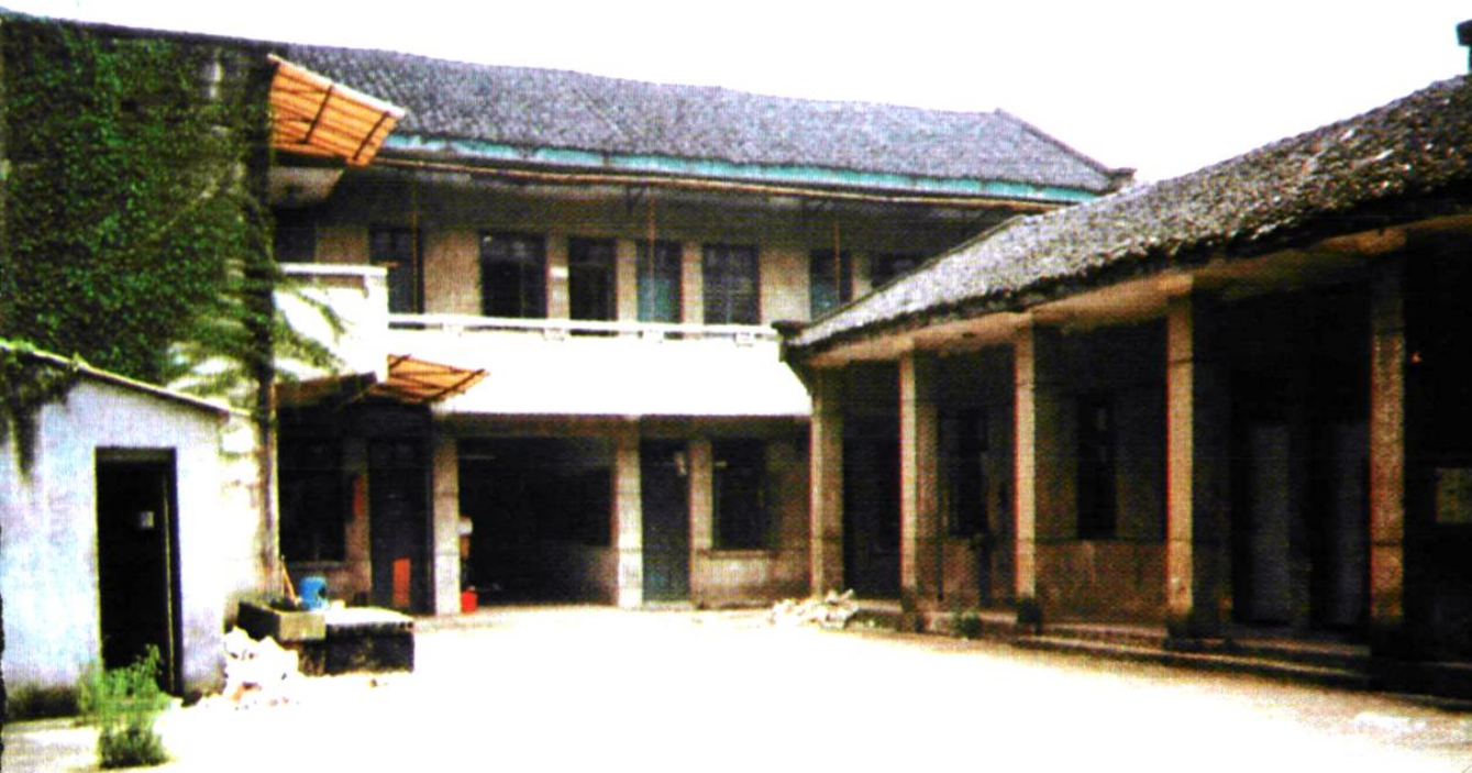
▲（原）温州轻纺技校拆建前的旧校舍（1984年初建）
