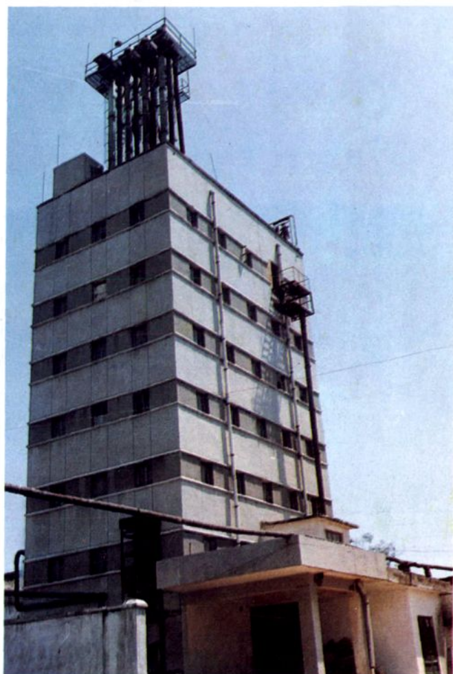
地直鹿寨蒸谷米厂全套引进美国设备的饲料厂（饲料一车间）厂房外景
