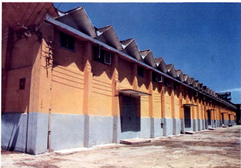
地直鹿寨蒸谷米厂仓储设施之一角
