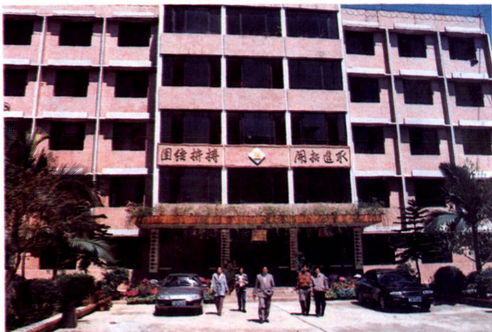
地直鹿寨蒸谷米厂办公大楼
