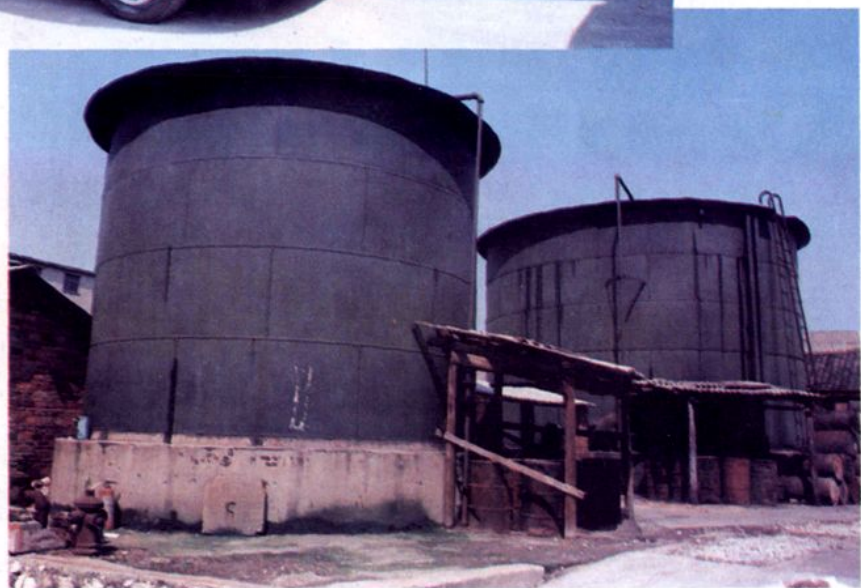
地区粮油贸易公司储油罐之一
