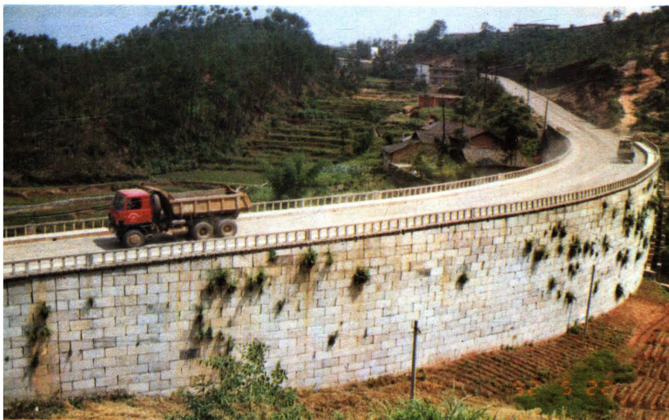
加筋土挡土墙
