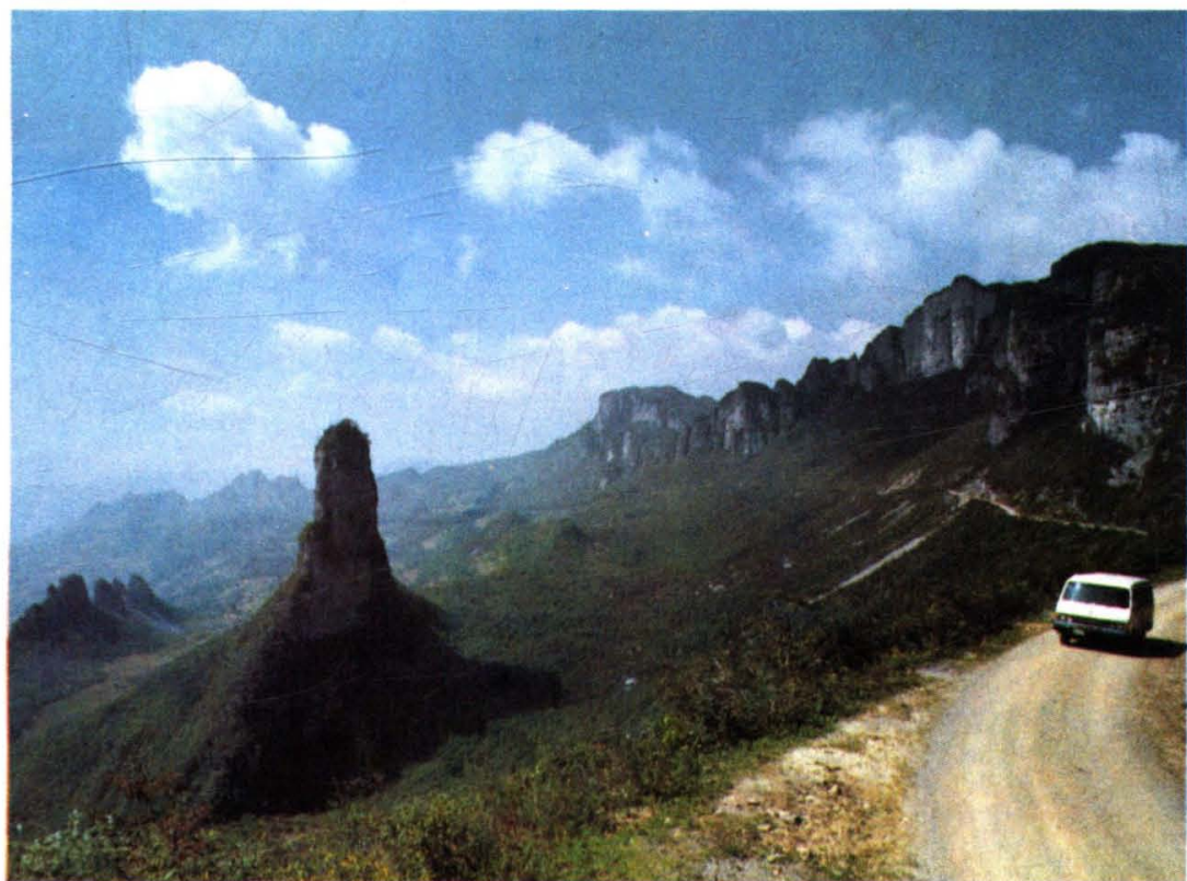
恩施市大山顶上的乡道公路
