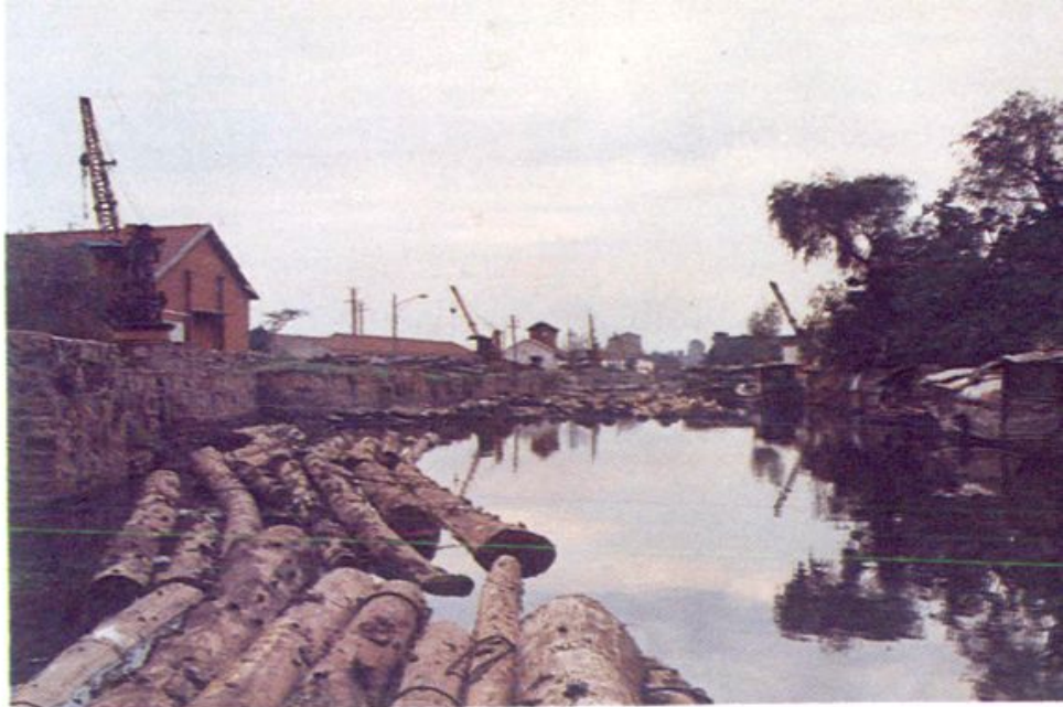
江阴市木材建材水上储木场
