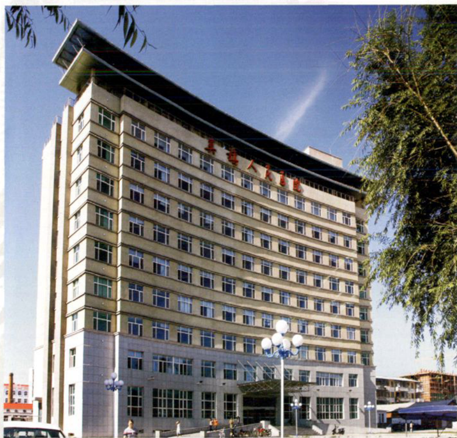
2006年建住院病房楼
