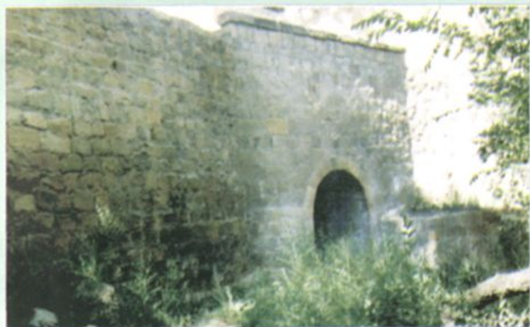
■ 贾家沟公路涵洞
