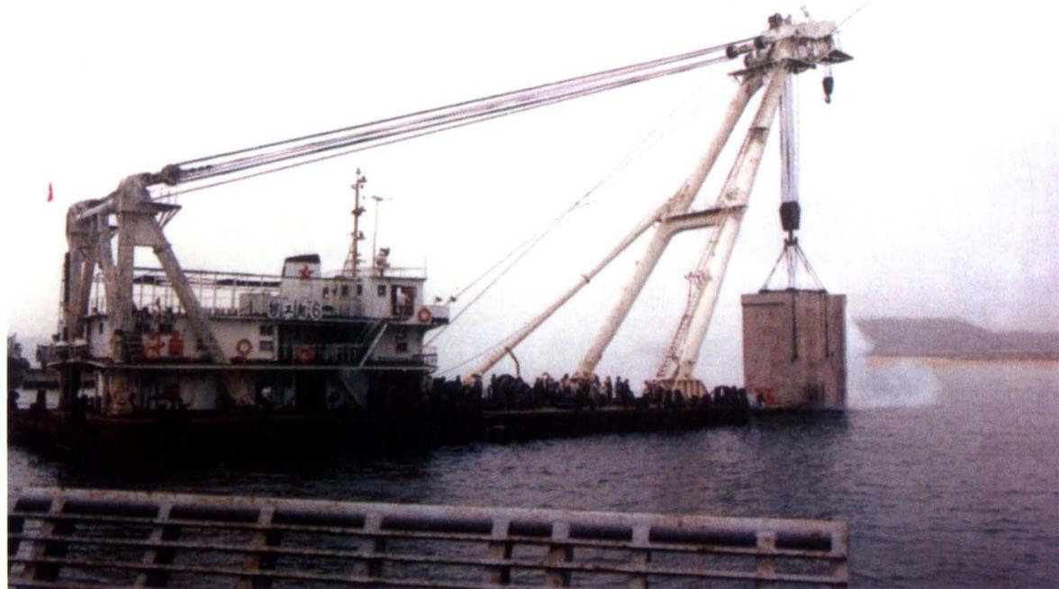
钦州港两个万吨级起步码头建设的第一个沉箱吊装场景。（《钦州港务局十年回顾》资料图片）
