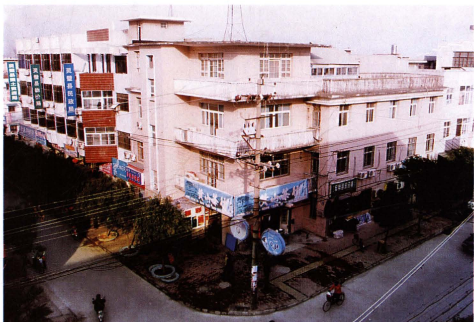
▲ 灵璧县民政局办公楼
