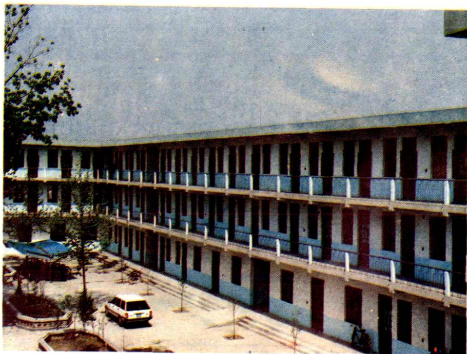
棉花加工一厂职工宿舍大楼
