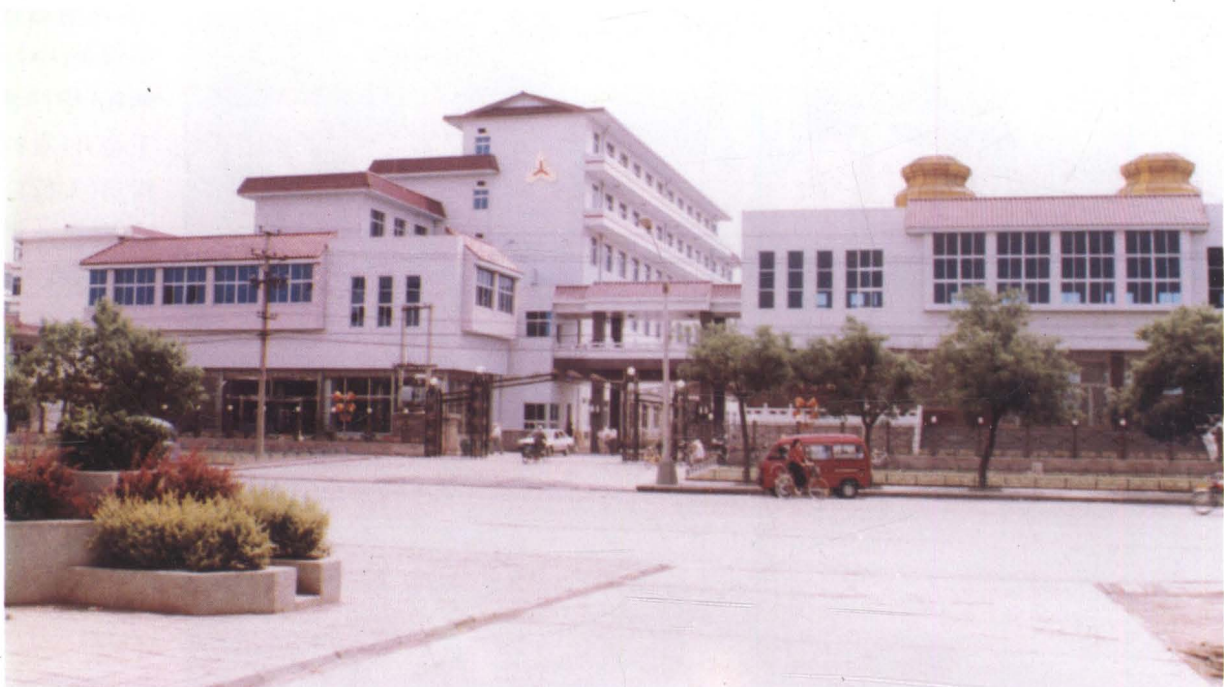
沧州人民银行办公楼
